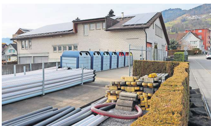
Der gemeinsam mit der Gemeinde Marbach geführte Werkhof und das Feuerwehrdepot in Rebstein sind sanierungsbedürftig. Der Gemeinderat beantragt einen Kredit in der Höhe von 1,3 Millionen Franken, um das Gebäude zu sanieren.
